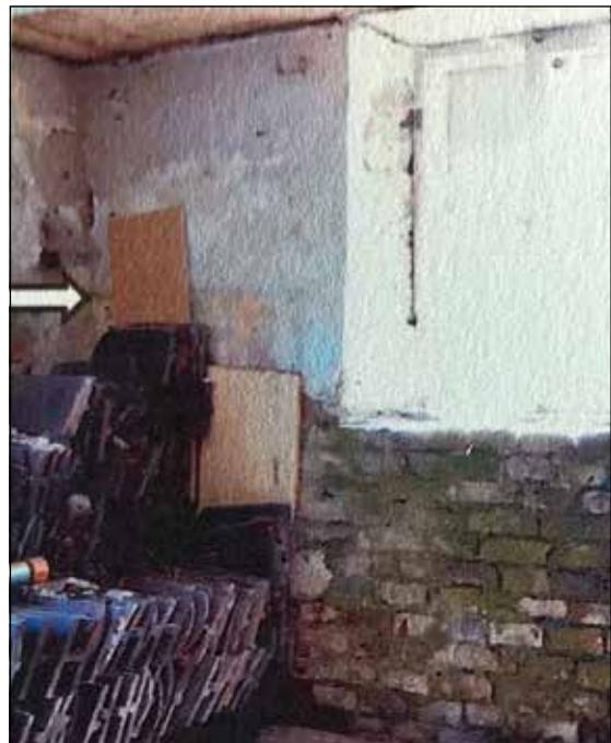
Edgeschoss Ostwand. Mit der Verkürzung des Mühlengebäudes 1850 wurde der Haupteingang nach Osten verlegt. Auf dem Bild sieht man die um 1900 wieder zugemauerte Türöffnung von 1850 sowie die Mauerfuge (Pfeil) an der Stelle, wo die neue Ostfassade an die Nordfassade angebaut wurde.
