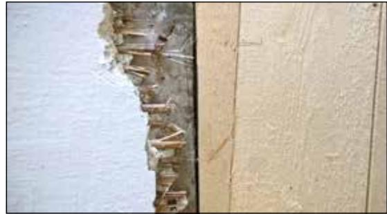
Erdgeschoss, Raum nach Norden. Historischer Deckenputz mit Schilfmatte als Putzträger.
