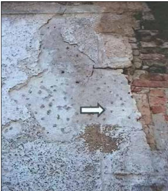
Bauzeitlicher Putz an der Süd-Westecke mit Eckquaderung
