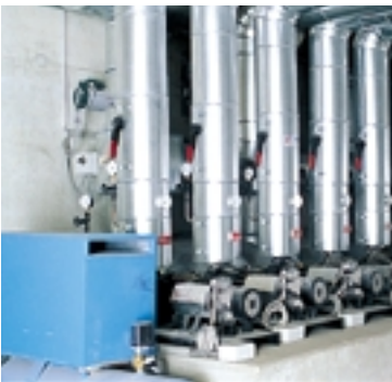
Drehzahlgeregelte Netzpumpen
