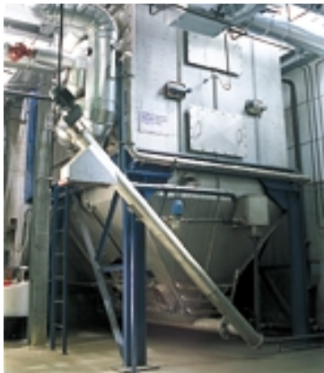
Rauchgaskondensationsanlage
